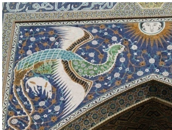
Gevelfersiering van de Divanbergi Madrasse
